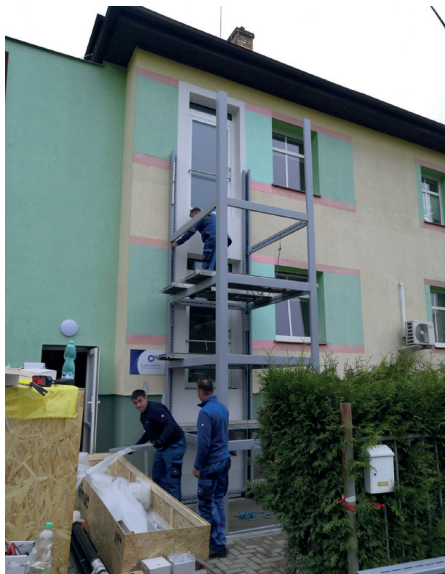
Instalace plošiny pro bezbariérový vstup do ordinace praktického lékaře.
