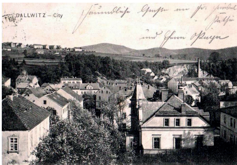
Historické foto: pohled na Dalovice z Hlavní ulice ze severovýchodu, vpravo budova dnešní pošty
