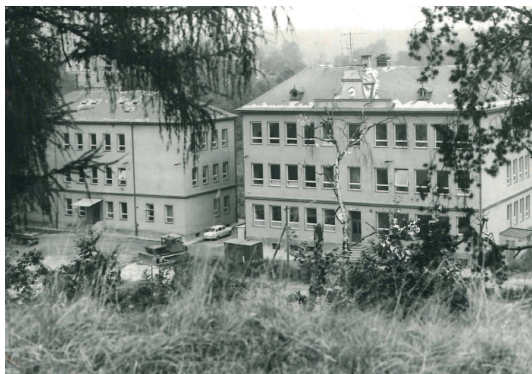
Foto ze školní kroniky - budovy školy po generální opravě na podzim 1968
